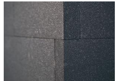
Abbildung 3 Die Wärmedämmplatten werden von der Unterseite der Wand aus kontinuierlich und versetzt nach oben verlegt. Auch in den Ecken sollten die Platten versetzt verlegt werden.
