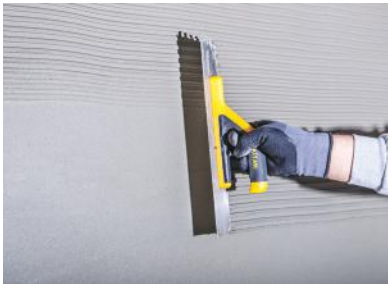
Abbildung 1 Nach dem Verkleben und Verdübeln der Istanbul Mavi Wärmedämmplatten wird die erste Lage Oberputz aufgetragen. Der vorbereitete Istanbul Mavi Putzmörtel wird mit Hilfe einer Stahlkelle gleichmäßig auf die Oberfläche aufgetragen. Die Auftragsdicke des Oberputzes sollte in jeder Schicht maximal 2 mm betragen.
