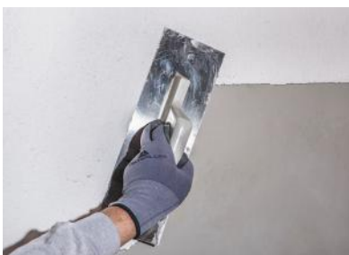
Abbildung 1 Mineralischer Strukturputz Istanbul Blue wird mit einer Kelle auf die Oberfläche aufgetragen
