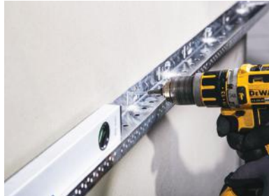
Abbildung 2 Nachdem die Oberfläche auf Gehrung geschnitten wurde Das Istanbul Mavi Subasman Profil wird mit Dübeln befestigt.
