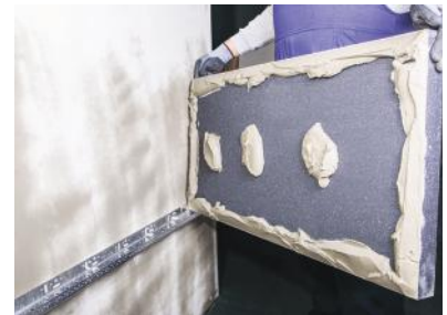
Abbildung 3 Beim Auftragen des Klebemörtels auf der Rückseite der Wärmedämmplatte ist darauf zu achten, dass er nicht über die Kanten hinausläuft.
